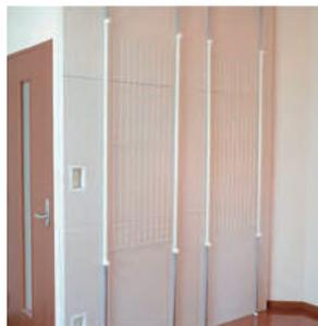
つっぱりポールを壁の手前に設置して、後ろからワンタッチ防音壁を設置する方法。壁紙を傷付けずに対策できるのがメリット。
