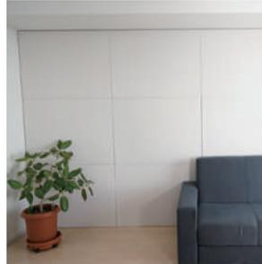
ワンタッチ防音壁の裏面に強力な両面テープを貼り付け、壁に設置する方法。最も安価に対策ができるのがメリット。
