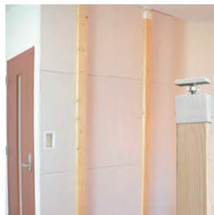
ラブリコと2×4材を壁の前に取り付けて、後ろからワンタッチ防音壁を設置する方法。壁紙を傷付けずに対策ができるのと、4つの方法の中で最も簡単に設置できる。
